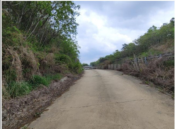
하부 도로 전경
