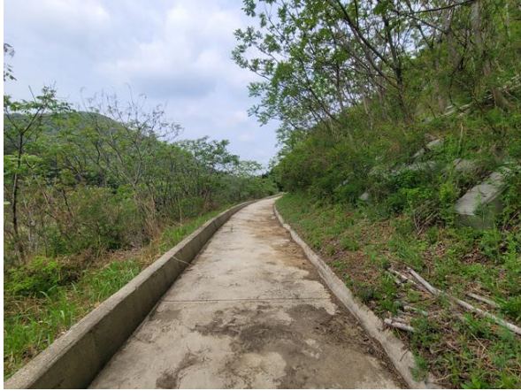
소단 배수로 전경
