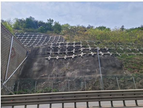
숏크리트, 격자앵커블럭 전경
