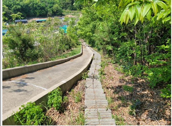
산마루측구, 점검계단 전경
