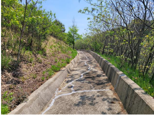
소단 배수로 전경
