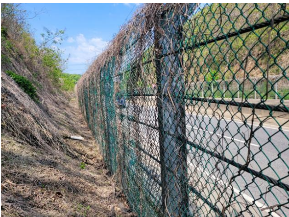
낙석방지울타리 및 하부 전경
