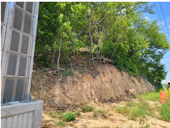
중점측 전경(공사중, 수원국토관리구간)
