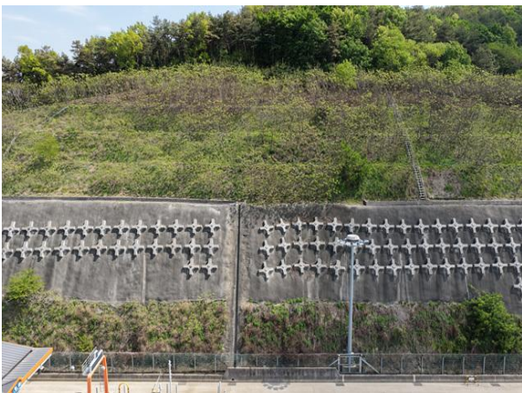
숏크리트, 격자앵커블럭, 수직도수로 전경
