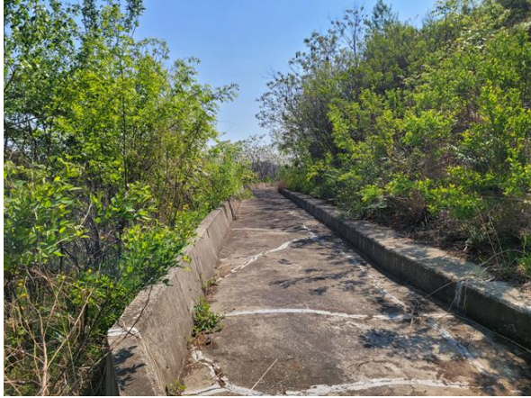
소단 배수로 전경
