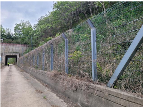
낙석방지울타리 및 하부 전경
