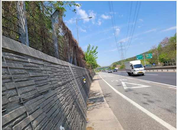
낙석방지울타리, 도로 전경
