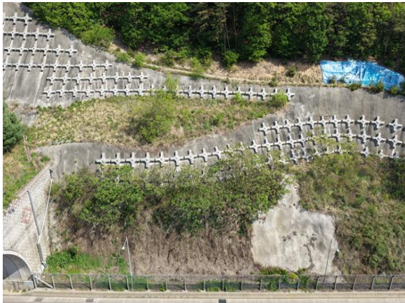
격자앵커블럭, 슛크리트 전경
