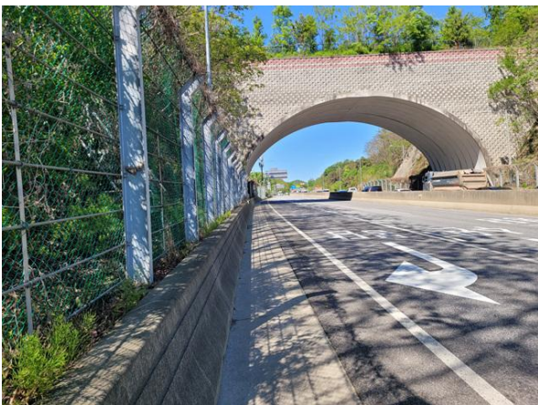
낙석방지울타리 및 하부 전경
